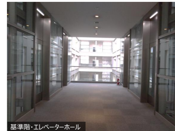
基準階・エレベーターホール
